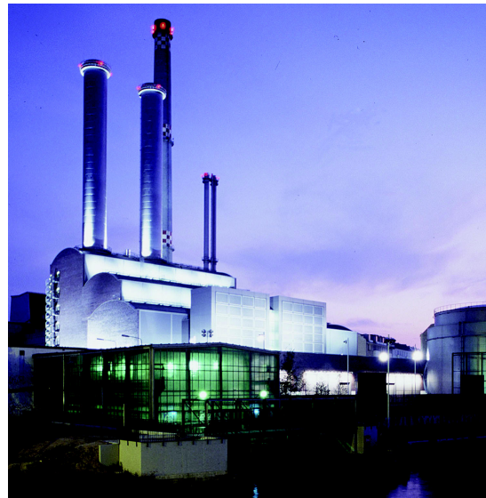
Abbildung 3: Modernes GuD-Kraftwerk in Berlin, Foto: Paul Langrock / Zenit / Greenpeace
